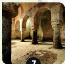
ALJIBE DEL PALACIO DE LAS VELETAS
